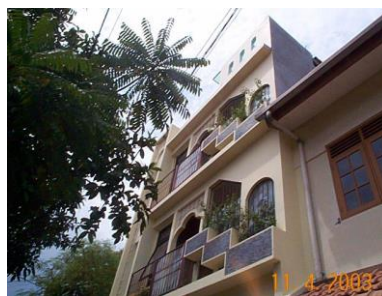
コンクリート製に見える家やビル の外壁のほとんどは実はレンガ製。
